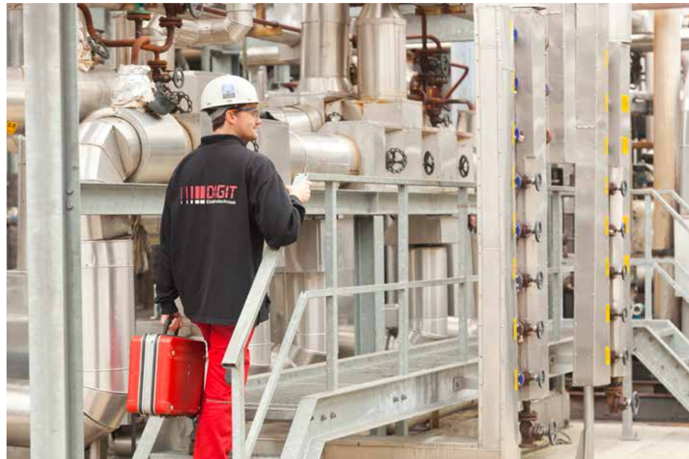
Onderhoudswerkzaamheden, uitgevoerd door DIGIT Elektrotechnik
