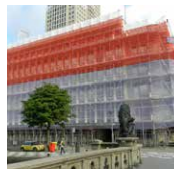
VAN DER PANNE STEIGERBOUW
