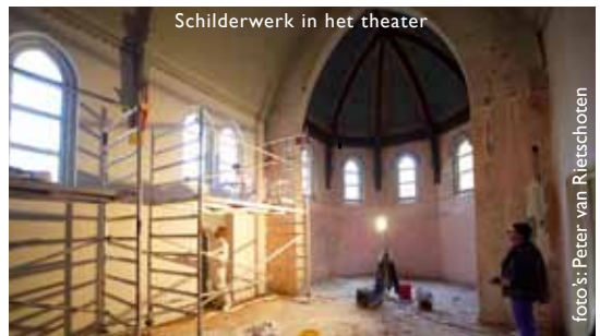
Schilderwerk in het theater
